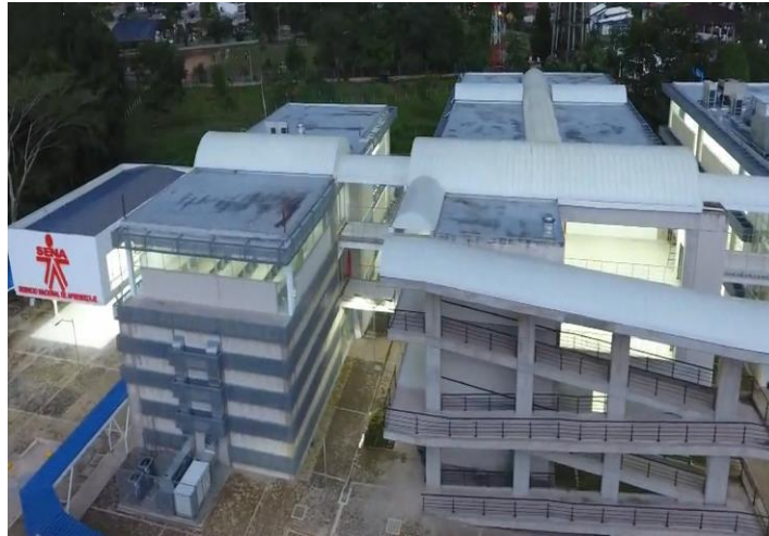
Ilustración 2. Construcción nueva sede SENA Guaviare
