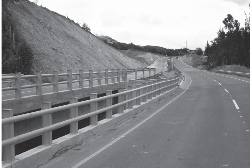
Fotografía 14. Doble calzada Briceño-Tunja-Sogamoso Fuente: Oficina Asesora de Prensa, Gobernación de Boyacá.
